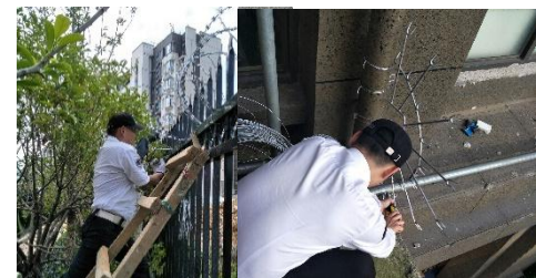
安装拉力刮刀、防爬刺
