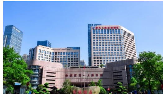
杭州余杭区第一人民医院
